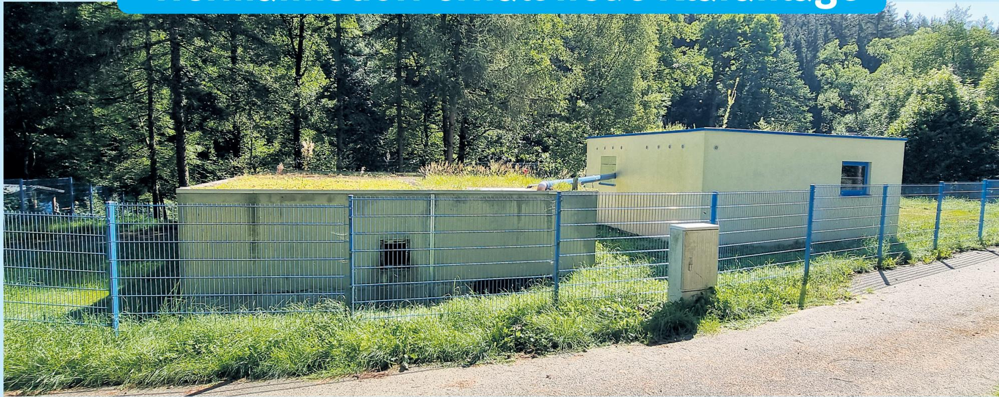
Am Ortsausgang von Hermannsdorf in Richtung Dörfel befindet sich die 1994 errichtete Rotationstauchkörper-Kläranlage für den Ortsteil. Mit 30 Jahren Nutzungsdauer kann die Kläranlage mit einer Kapazität von 1.000 Einwohnergleichwerten in dieser Bauweise ihre Reinigungswerte nicht mehr sicher einhalten, so der Geschäftsführer des Zweckverbandes Wasserwerke Westerggebirge (ZWW), Dr. Frank Kippig.
